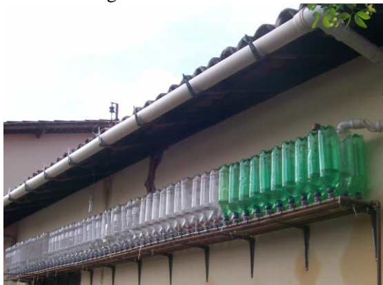
Figura 4: RAAC instalado
